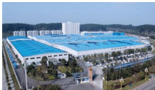
南充三环（一厂区）
