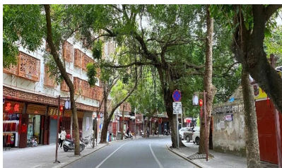
捐建中山路整体改造工程
